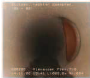
Sanierter Hausanschluss
