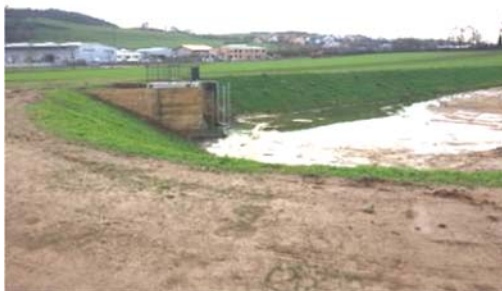
Blick von Nordosten über den südlichen Teil des Plangebiets, im Vordergrund das RRB (Quelle: BBP, Kaiserslautern 2016)
